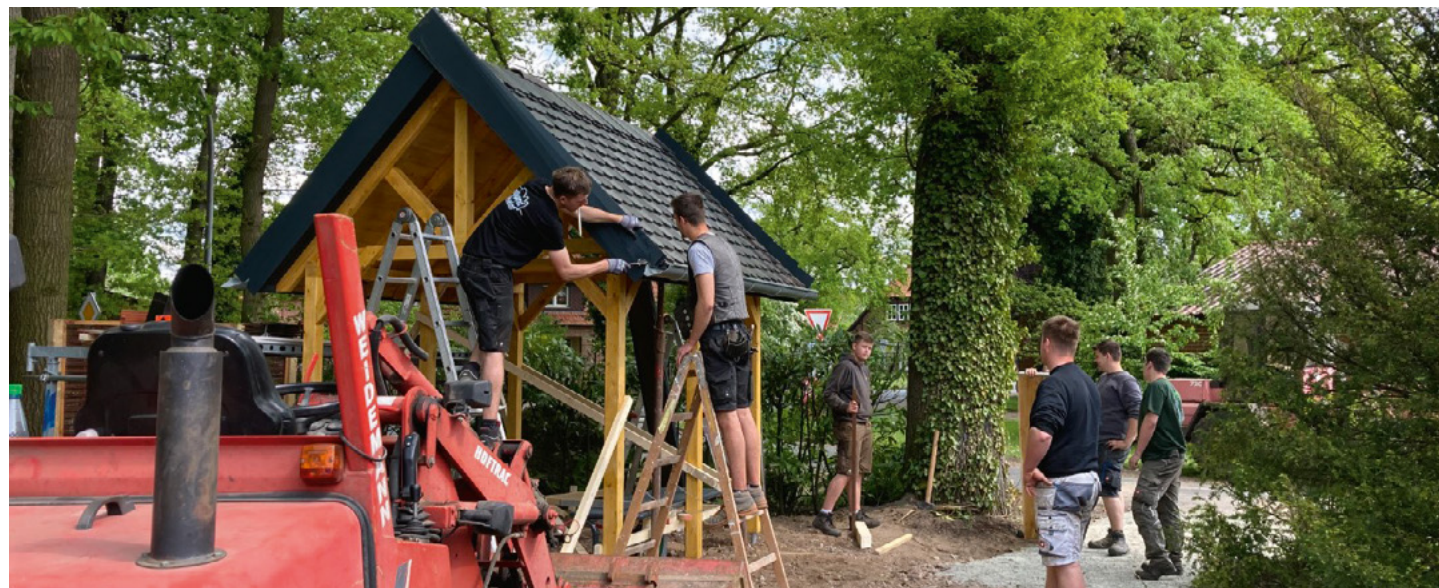
Handwerkliches Geschick und die passenden Gerätschaften halfen der Landjugendgruppe Wohlsdorf beim Bau des Unterstandes.
